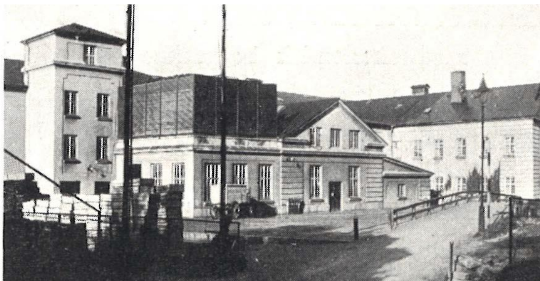
Fryshuset modell 1919 från sydöst avbildad 1929. Lägg märke till de kraftiga hörnkedjorna, påbyggnaden i plåt med hisstorn bakom, och L-formen med en bortre gavel mot nuvarande Skärgårdsgatan.
