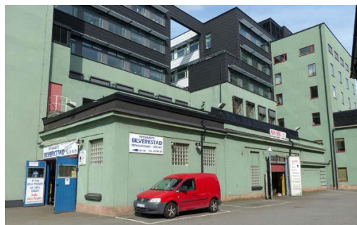
Del av ursprungsbyggnaden idag.
